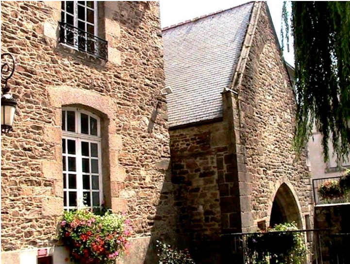
Dinan, Theater des Jacobins. Oben: das Gebäude vom antiken Dominikaner Noviziat und das Dach der Tour de l'Horloge (Clock Tower); Unten: die alte Kirche und das Noviziat.
