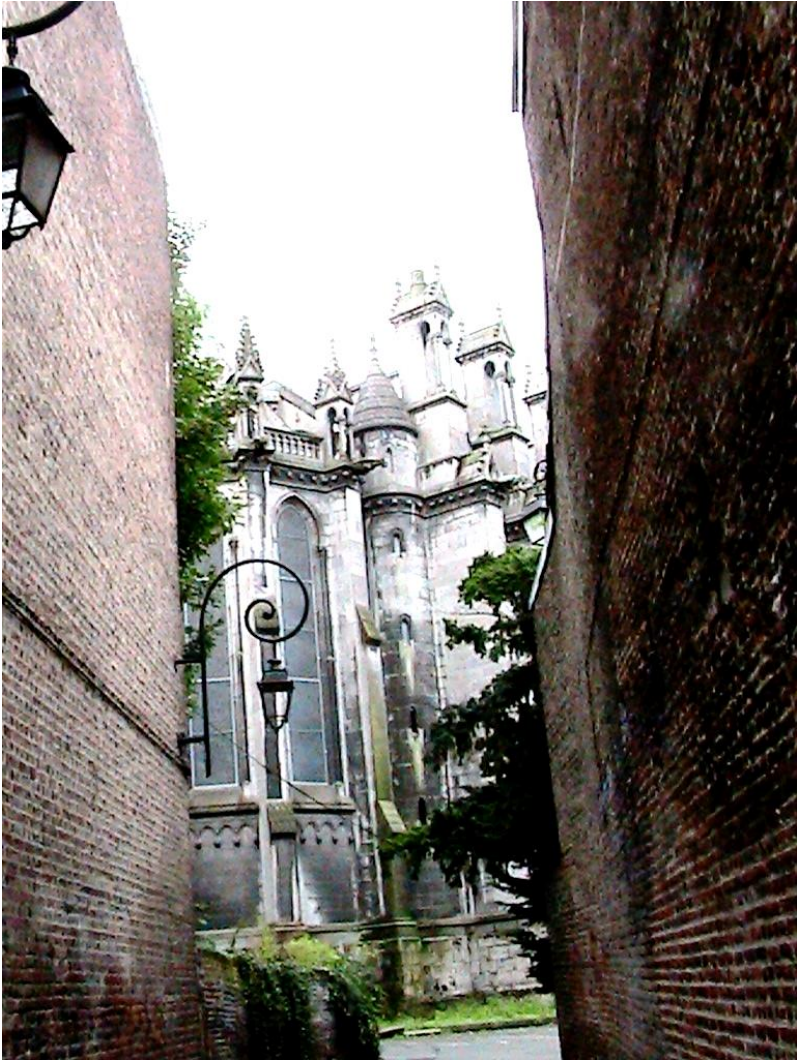
In der Rue de la Monnaie, vor den Hospice de la Comtesse und den Ruinen der Dominikaner gibt es eine Passage für die Kirche Notre Dame de la Treille.
