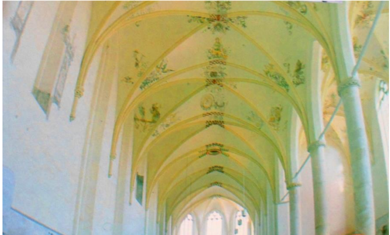
Zwolle, die Kirche der Dominikaner, genannt Broerenkerk, vor den Restaurationsarbeiten 2012.
