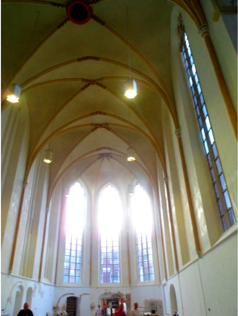
Zwolle, die Kirche der Dominikaner, genannt Broerenkerk, während der Restaurationsarbeiten 2012.
