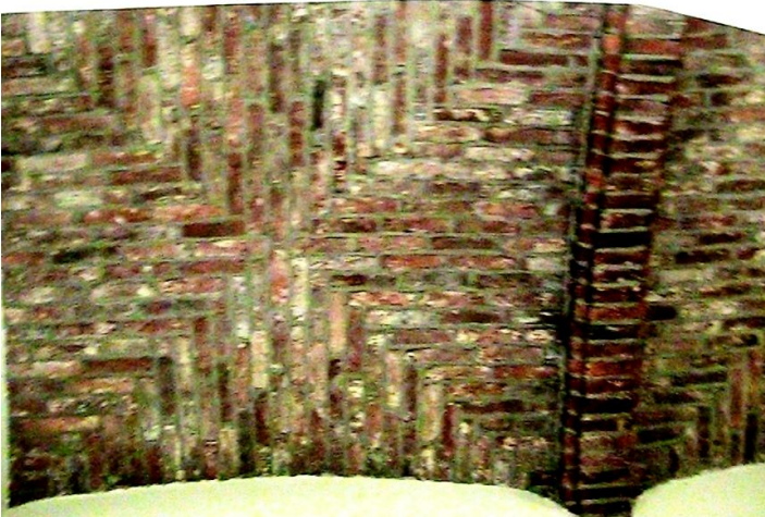
Gand, antikes Kloster der Domenikaner: Treppenhaus (oben); Antike Ziegelsteindecke (unten).
