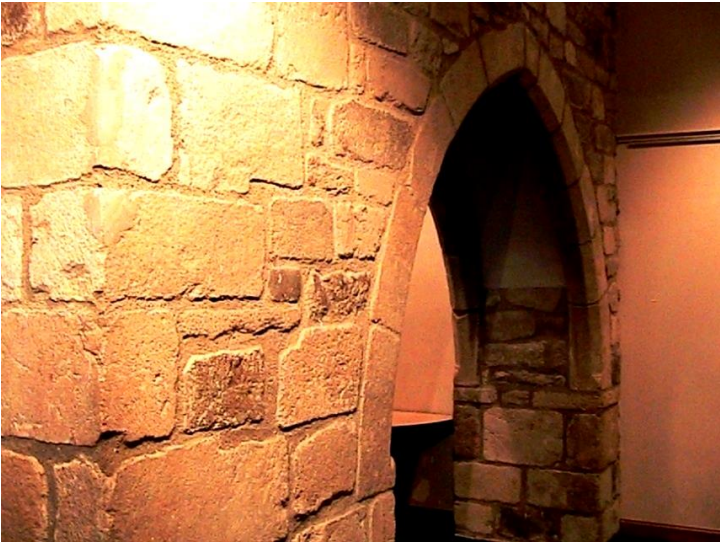
Dinan, Theatre des Jacobins : Im Inneren der alten Kirche des Dominikaner Noviziat befinden sich die Verbindungswände/Gänge zwischen der Kirche und dem Kloster.
