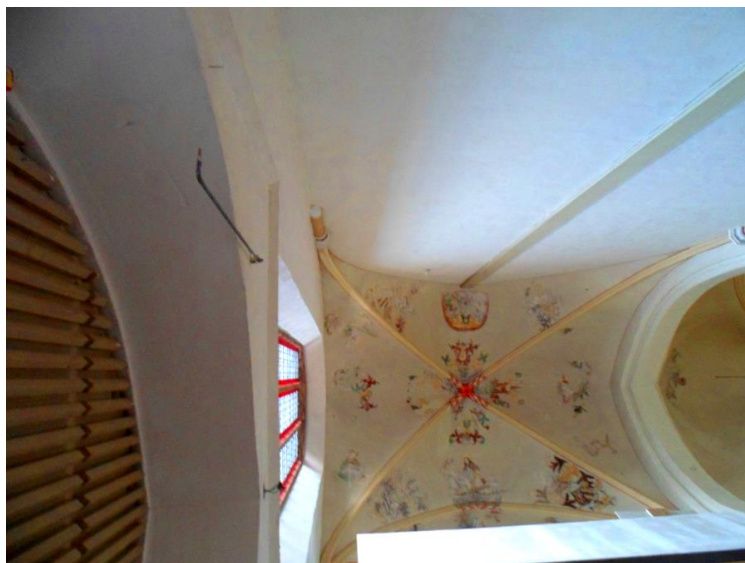
Zwolle, die Kirche der Dominikaner, genannt Broerenkerk, während der Restaurationsarbeiten 2012.
