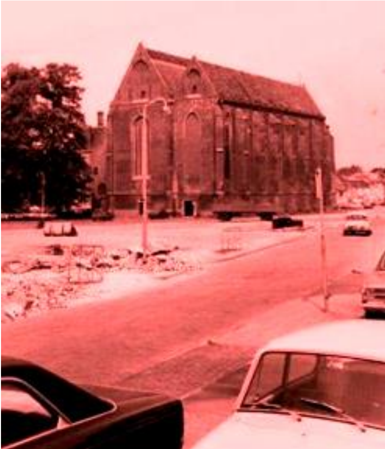
Zwolle, die alte Kirche der Dominikaner, genannt Broerenkerk, in den 60er Jahren. Die neuen Gebäude gab es derzeit noch nicht.
